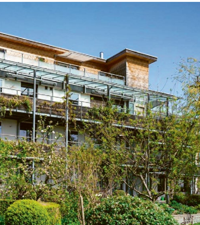
Alterswohnheim Bodana, Salmsach/TG
